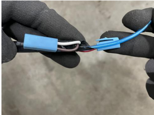
Abbildung 7: Befestigung der Steckanschlüsse an der Einziehhilfe
