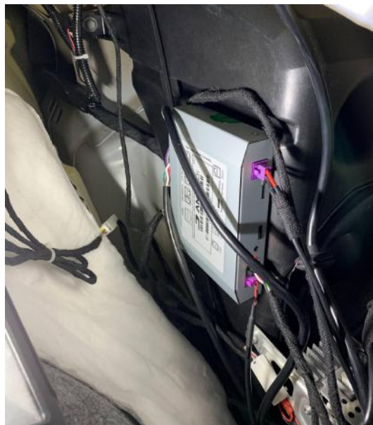
Abbildung 24: Anbringung der zentralen Steuereinheit
